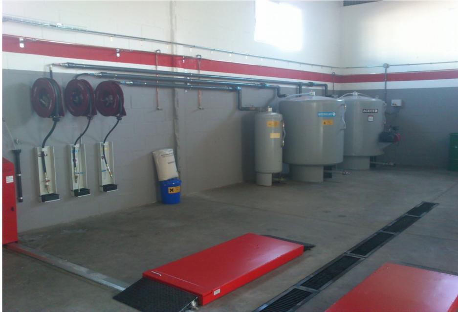
La nueva versión de equipos de aspiración de vacío diseñados por Grupo Emar ofrece la máxima eficiencia en aspiración (el 99% de efectividad sobre el -1 bar, la máxima depresión físicamente posible), cumpliendo a la vez con todas las normativas europeas referentes al almacenaje de productos petrolíferos. El cubeto de retención queda completamente integrada al depósito, ofreciendo al mismo tiempo todas las garantías de funcionamiento y proyectando un diseño innovador del equipo.
